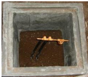
चित्र 3.5 : इन्स्पेक्शन चैम्बर (Inspection Chamber)
